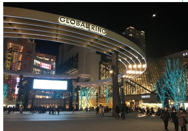
池袋西口公園野外劇場 グローバルリング シアター
